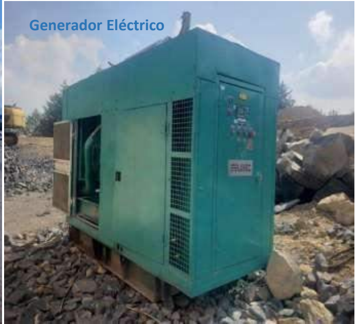
TRASLADO DE MAQUINARIA DE TRITURACIÓN EN SITIO
